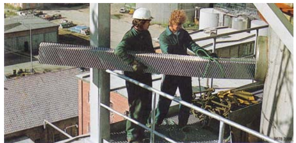
Foto 1. L'installazione di un elemento di riempimento strutturato in una colonna di grandi dimensioni
