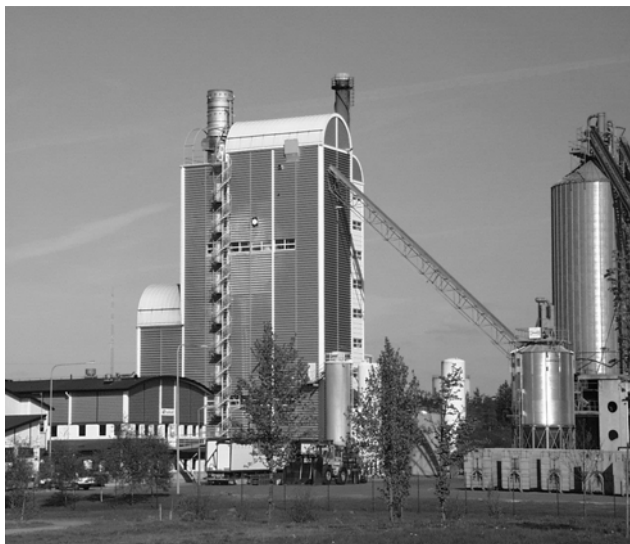
Figura 1. Sito e impianto del Värnamo Biomass Gassification Centre.
